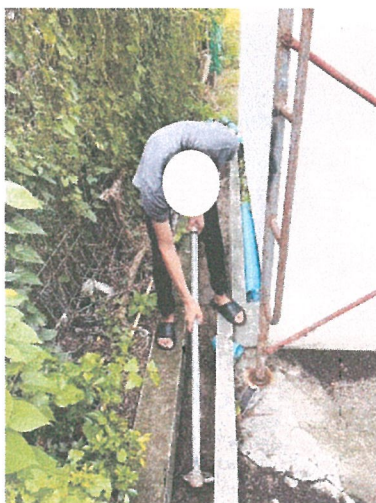
รูปภาพที่ 2.8 การขุดลอกตะกอน
