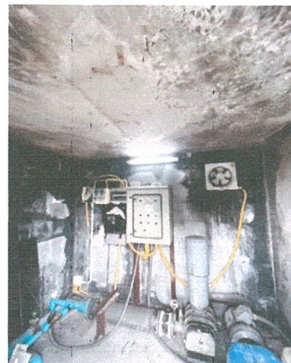
รูปภาพที่ 2.35 เครื่องเติมอากาศระบบบำบัดน้ำเสีย
